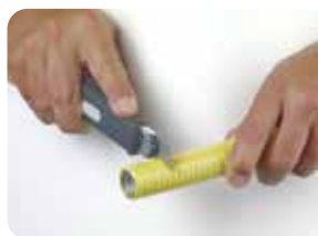
Dénuder le tuyau flexiPIPE à l'aide d'un cutter
