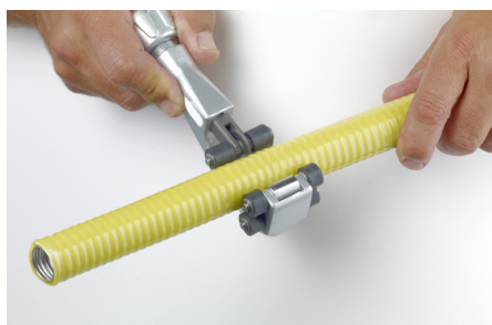
Couper le tuyau flexiPIPE ® avec un coupe-tube inox adapté.
