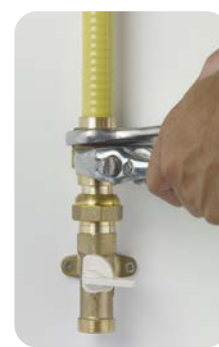
6. Terminer le serrage en butée
