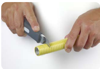
Dénuder le tuyau FlexiPIPE® à l'aide d'un cutter
