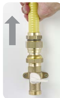
5. Contrôler le l'enclenchement du tuyau Flexi-PIPE® par traction
